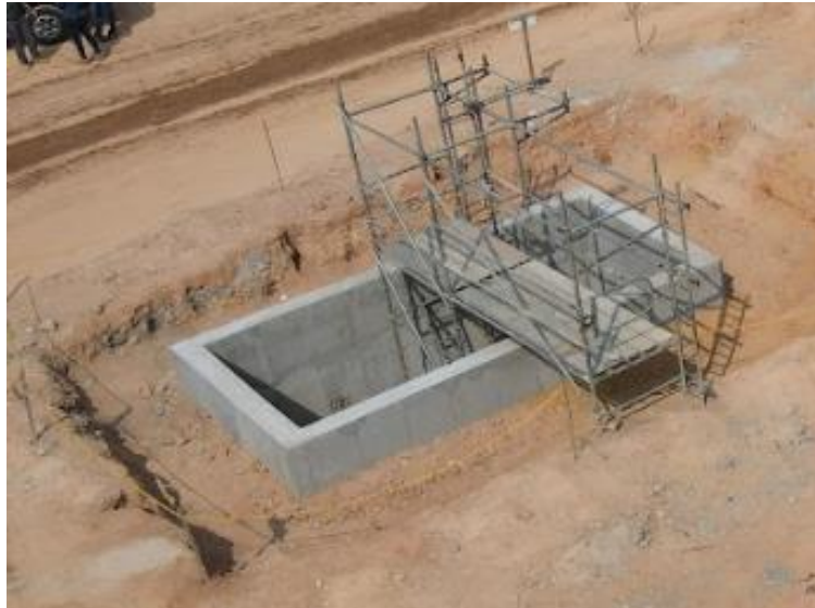
Tanque de almacenamiento de lodos digeridos Instalación de formaleta de muros.
