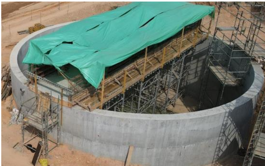
Tanque de almacenamiento de lodos digeridos Instalación de formaleta de muros.
